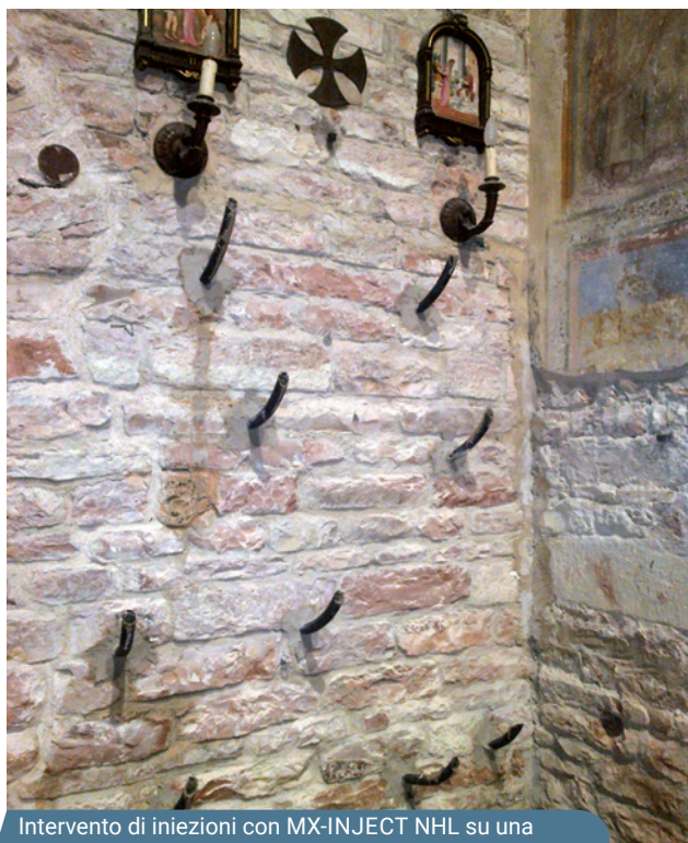
Intervento di iniezioni con MX-INJECT NHL su una struttura in muratura.
