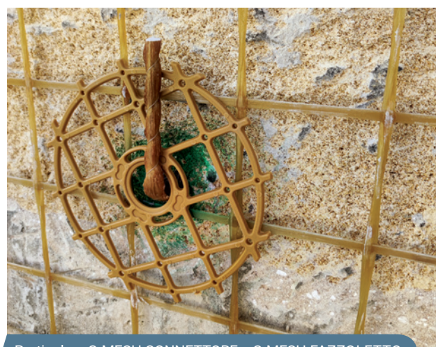
Particolare G-MESH CONNETTORE e G-MESH FAZZOLETTO.
