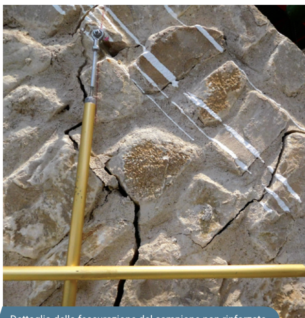
Dettaglio della fessurazione del campione non rinforzato.
