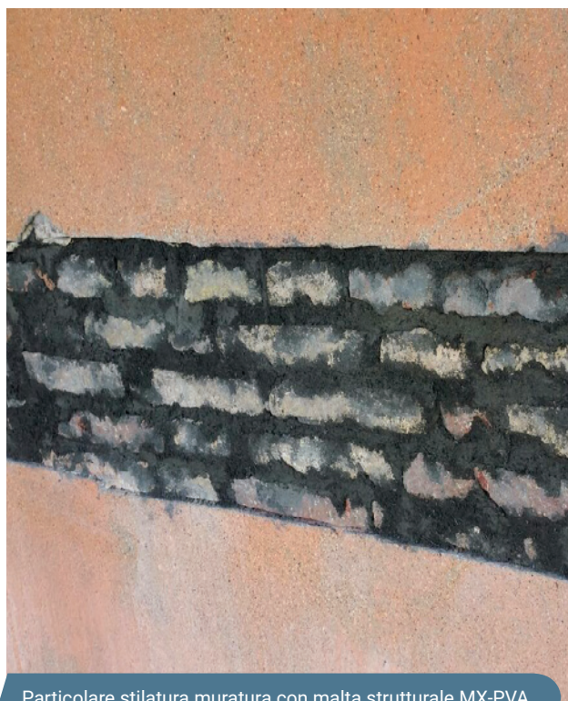
Particolare stilatura muratura con malta strutturale MX-PVA.
