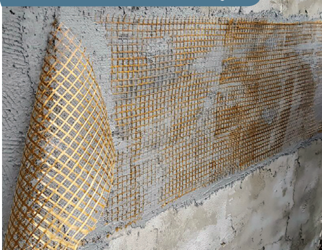
Sistema FRCM, con rete in PBO e matrice inorganica.
