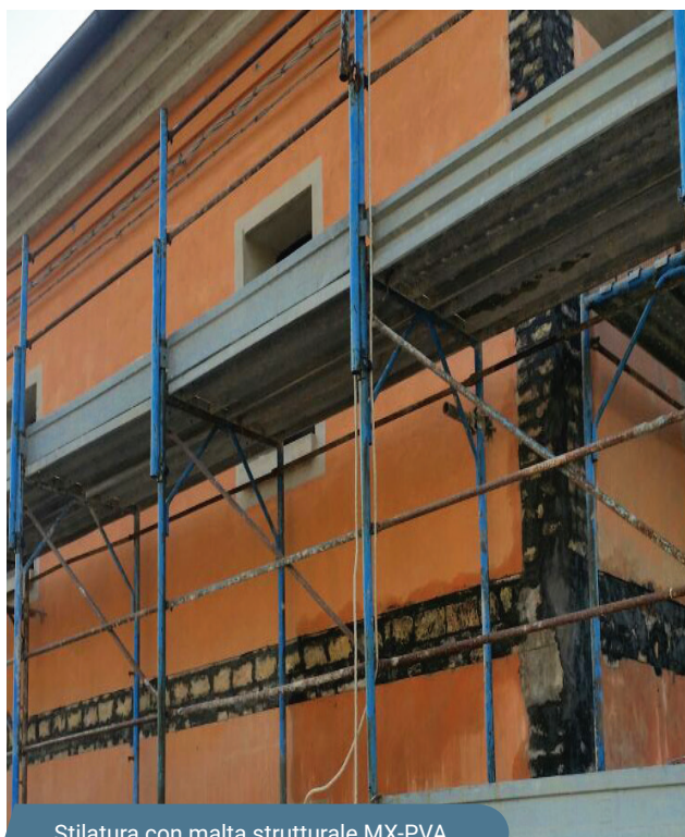
Stilatura con malta strutturale MX-PVA.
