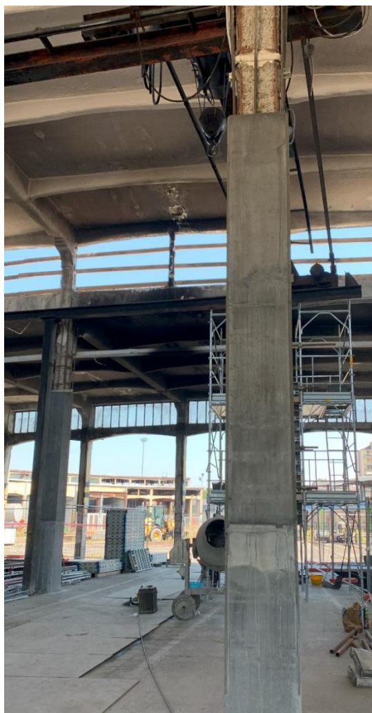
Figura 1 - Ringrosso (jacketing) di pilastro mediante MICRO GOLD STEEL.
