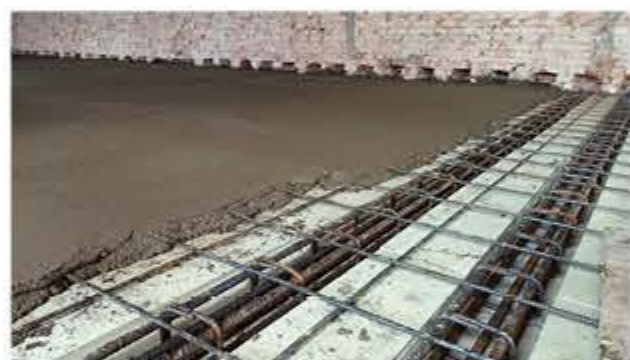
Posa connettore chimico e getto cls leggero
