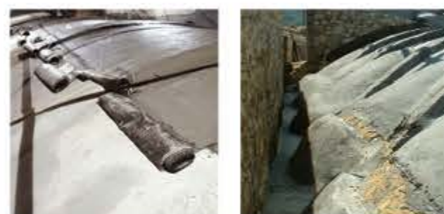
Applicazione del sistema FRCM
