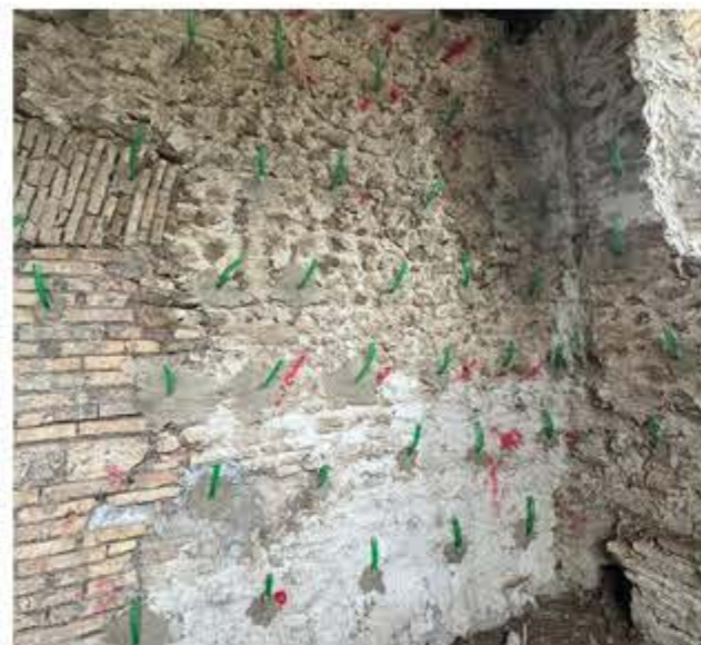
Inserimento tubi da iniezione
