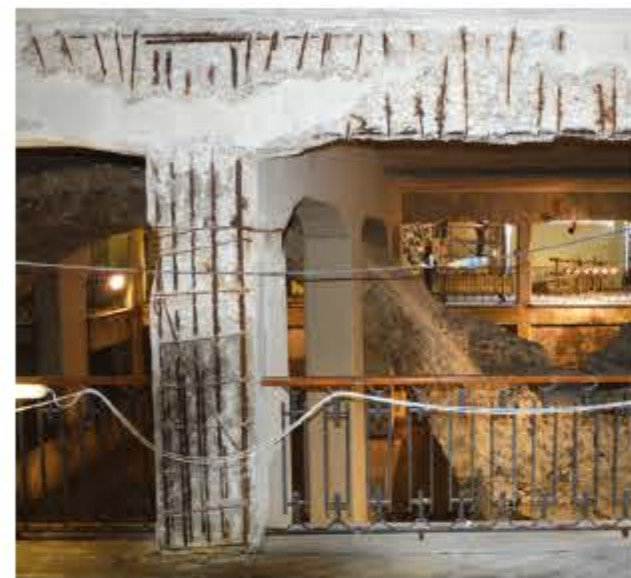
Preparazione del substrato
