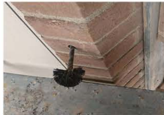
Inserimento delle barre FRP
