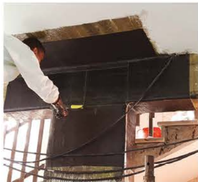
Applicazione del rinforzo FRP
