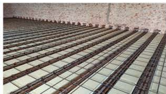
Preparazione irrigidimento fuori spessore
