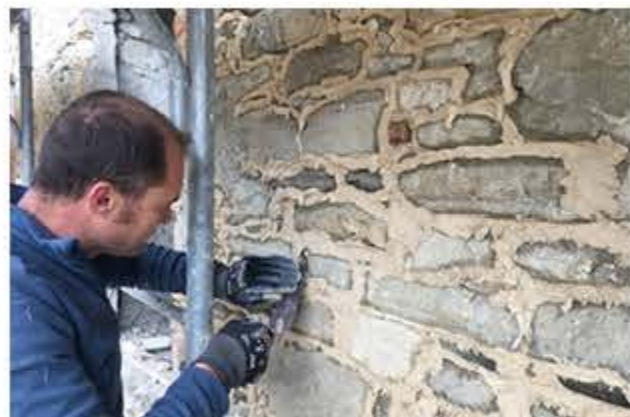
Ristilatura dei giunti
