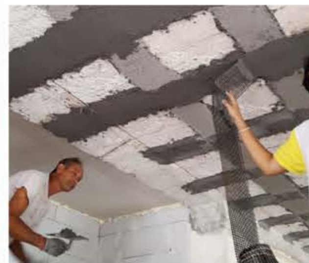
Preparazione del substrato
