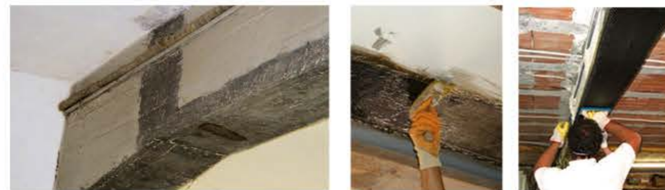
Preparazione del substrato
