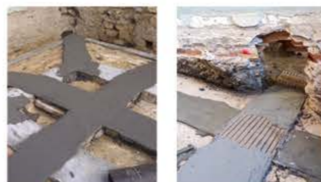
Applicazione del sistema FRCM
