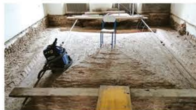
Preparazione del substrato
