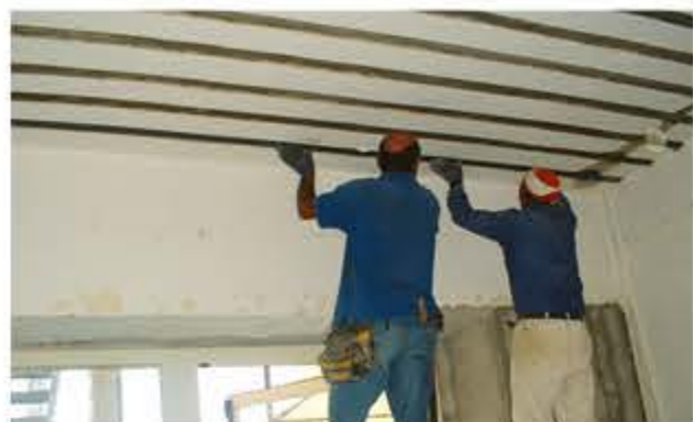
Applicazione del rinforzo FRP
