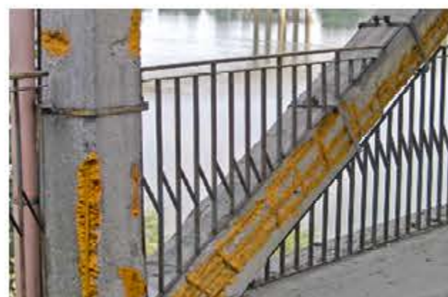
Ricostruzione copriferro con MX-R4 ripristino
