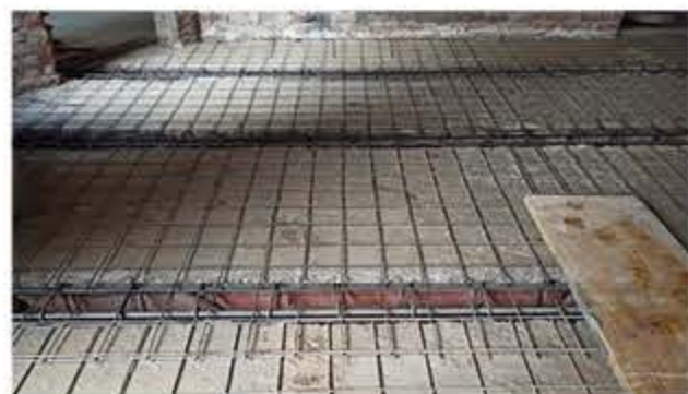
Posa connettore chimico e getto cls leggero
