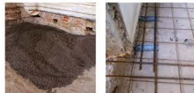
Riempimento leggero e sistema Perimetro Forte
