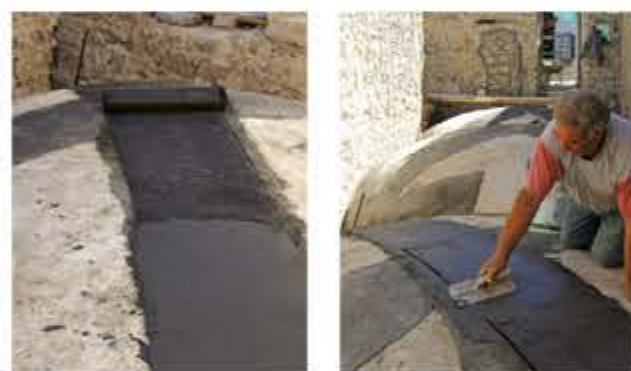
Applicazione del sistema FRCM
