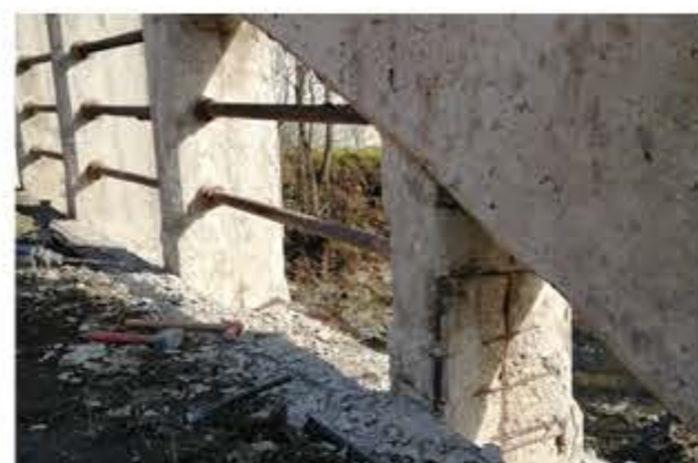
Scarifica del substrato
