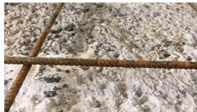
Preparazione del substrato
