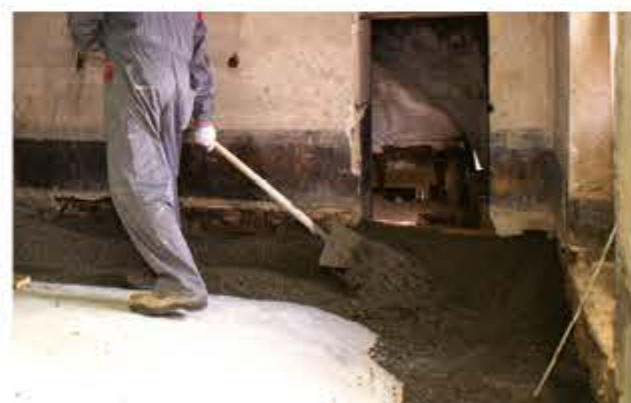
Riempimento leggero e sistema Perimetro Forte
