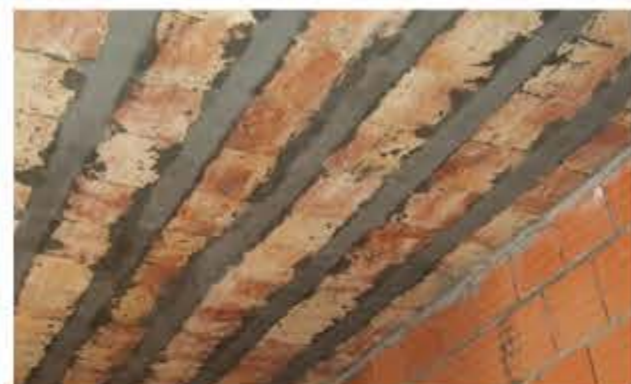
Preparazione del substrato
