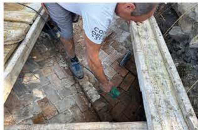
Intervento scuci-cuci e ristilatura
