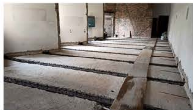
Preparazione irrigidimento in spessore
