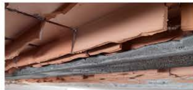
Scarifica del substrato
