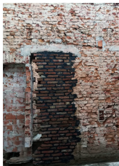
"Cucitura" e ricostruzione con MX-PVA
