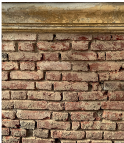
Scarifica profonda dei giunti degradati
